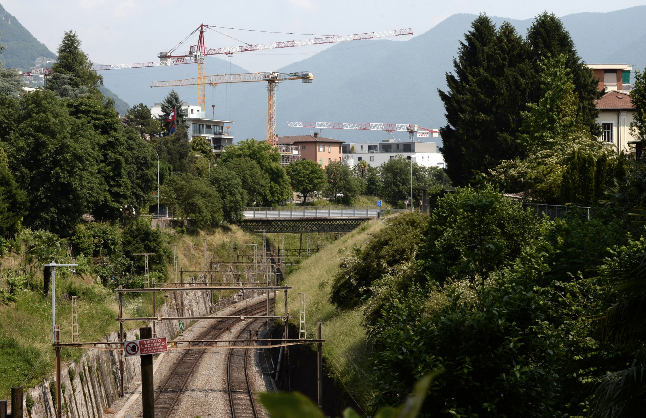
Vista 2 verso Sud-Est da portale galleria FFS: Stato di fatto
